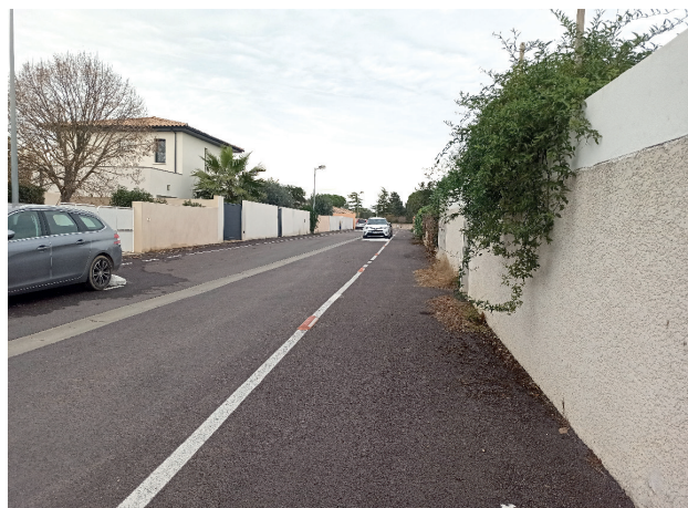
Fin réfection chemin des Accates.
