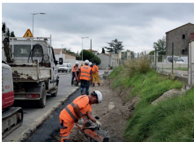
Mise en place d'une buse et piste cyclable. Route de Lunel-Viel.
